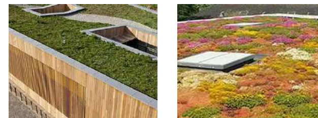
Exemples de système de végétalisation : Toundra (Soprema) et Saxatilis (Ecovégétal)
